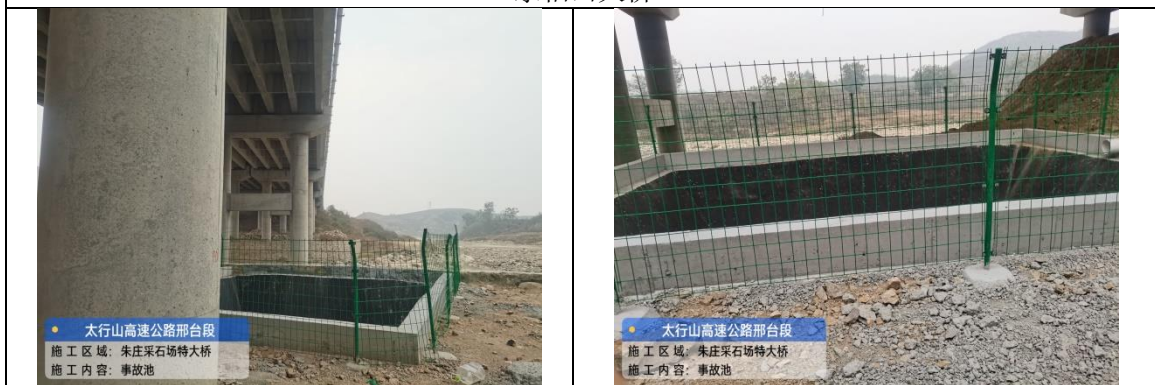
朱庄采石场特大桥
