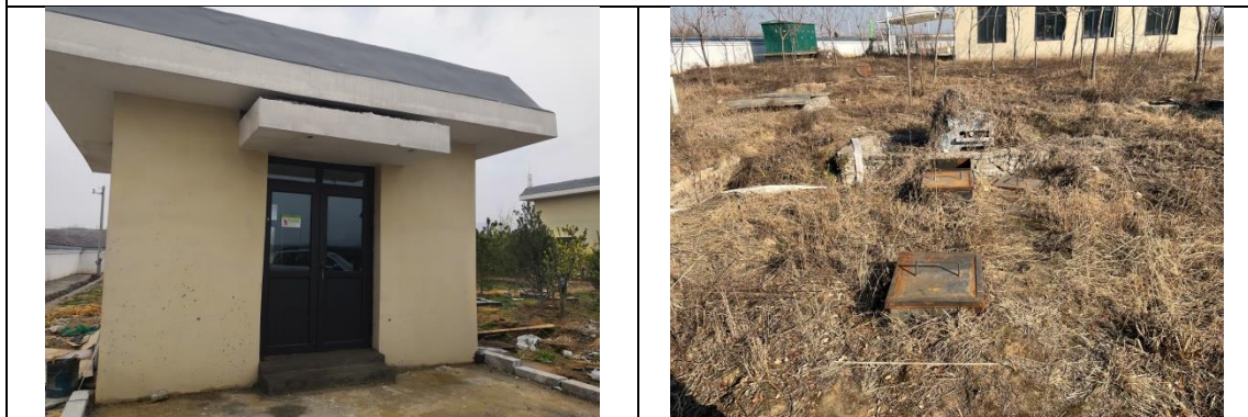
临城服务区污水处理设施
